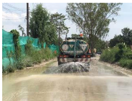
รูปที่ 2-11: การฉีดพรมน้ำบริเวณเส้นทางขนส่งแร่
